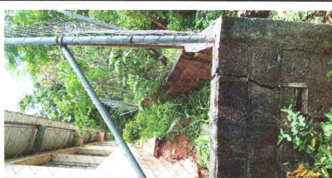
Foto 4: Sustitución por deterioro de la base del block
